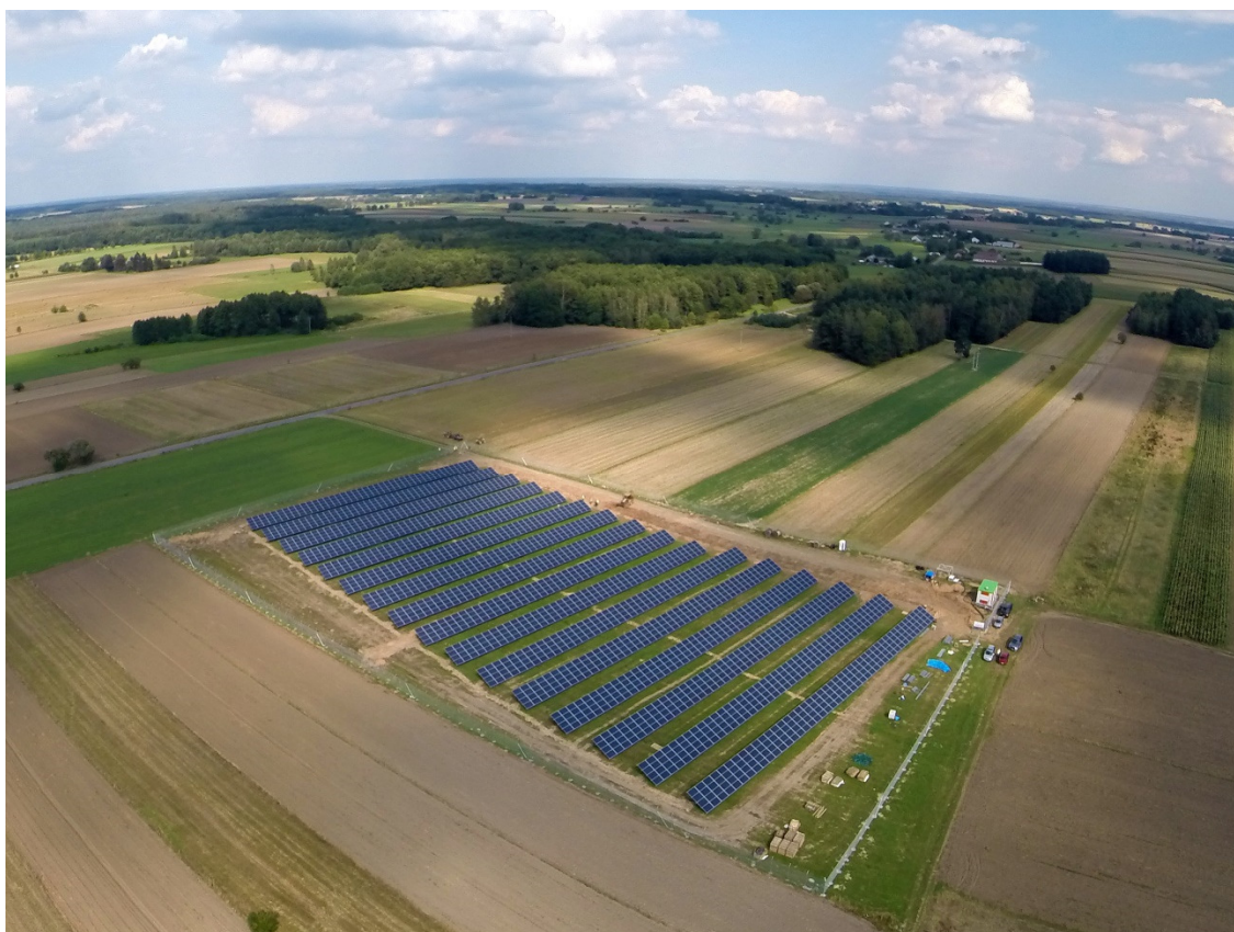
Elektrownia Słoneczna R.Power - Jedwabne
